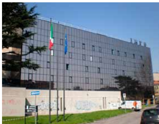
La sede dell'Inps di Lodi prima (a sin.) e dopo l'applicazione della pellicola Serisolar
