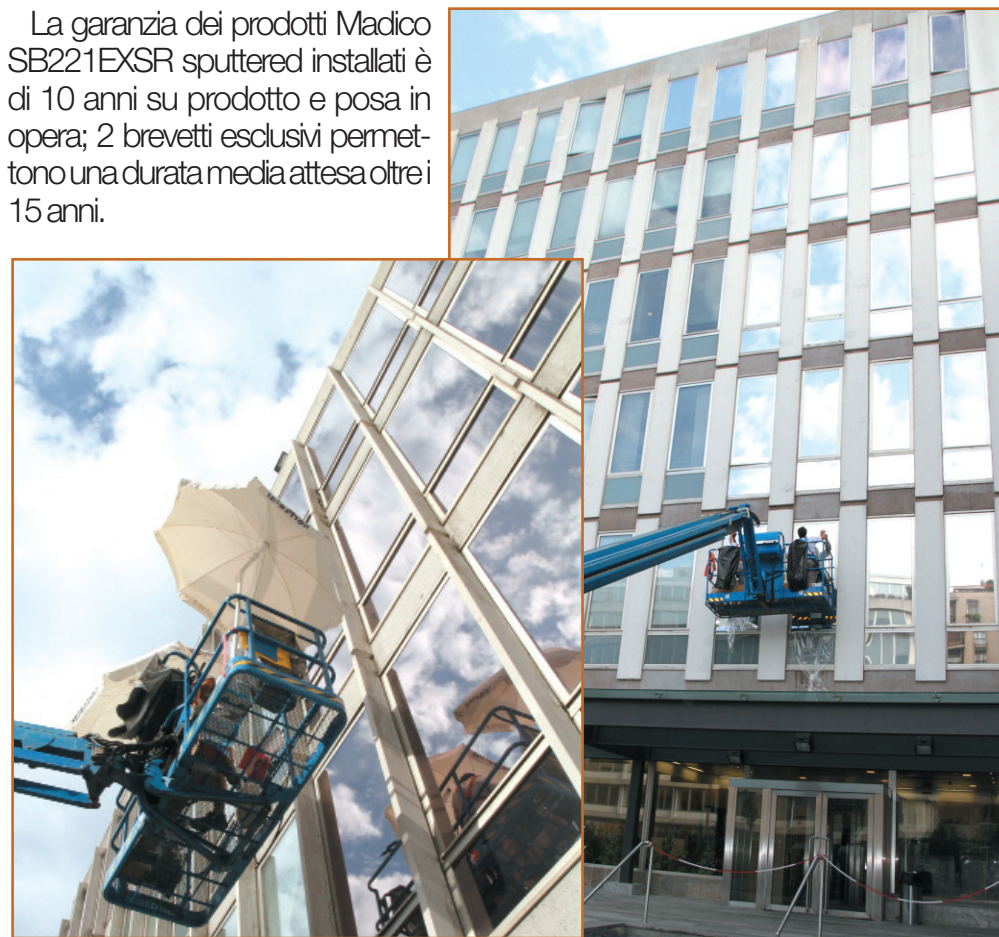
Le sedi di Unicredit e Fineco durante l'intervento di Serisolar
