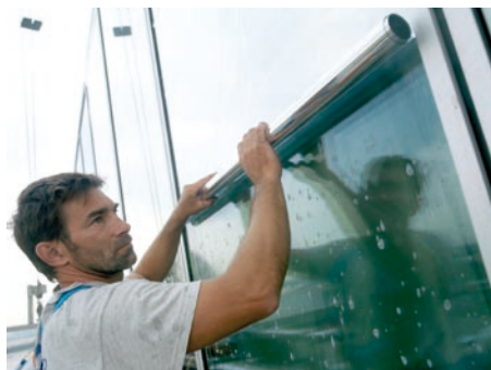
Zum Schutz von Kunstschätzen: Ein Installateur bringt die Folien an den Museumsfenstern an
