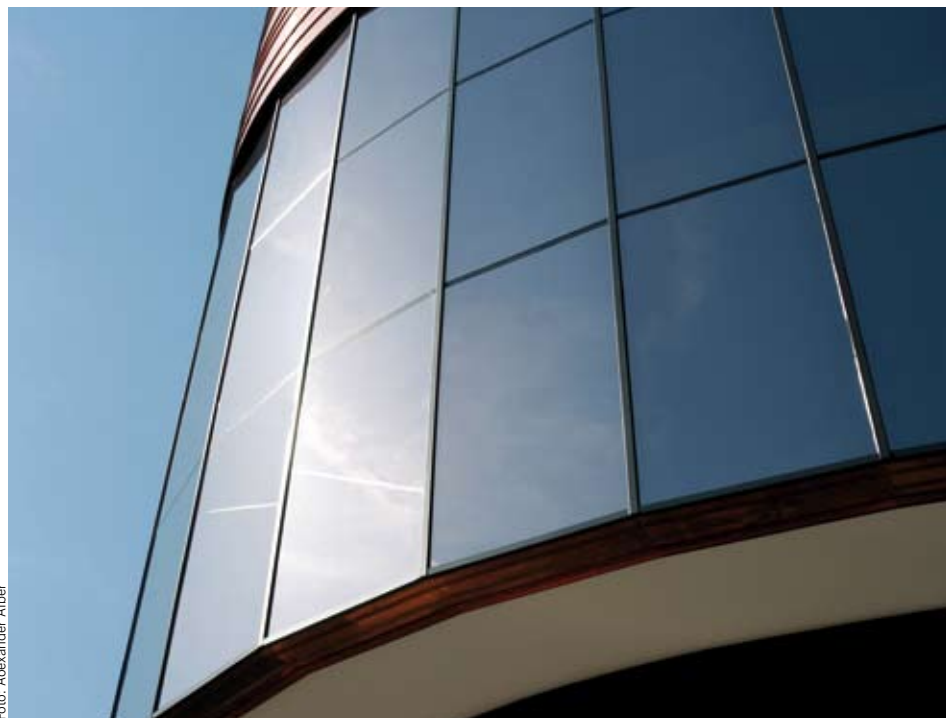
Dank der Sonnenschutzfolien von Serisolar können die Kosten für die Klimatisierung an der Talstation der Rittner Bahn um 30 bis 50 Prozent reduziert werden
