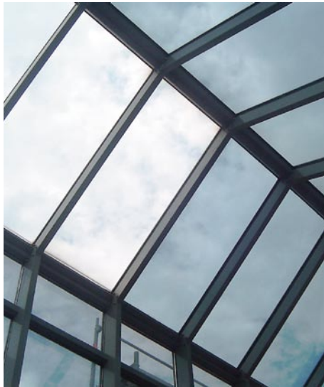
Zwei Details einer Glasfront, bei der Serisolar Sonnenschutzfolien angebracht hat; an den helleren Scheiben fehlt die Folie noch, die dunkleren sind schon bearbeitet
