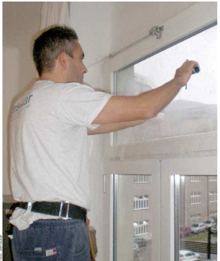
Die Experten von Serisolar überprüfen das Glas mit einem Laserinstrument und wandeln es durch das Anbringen einer Klebefolie in Sicherheitsglas um
