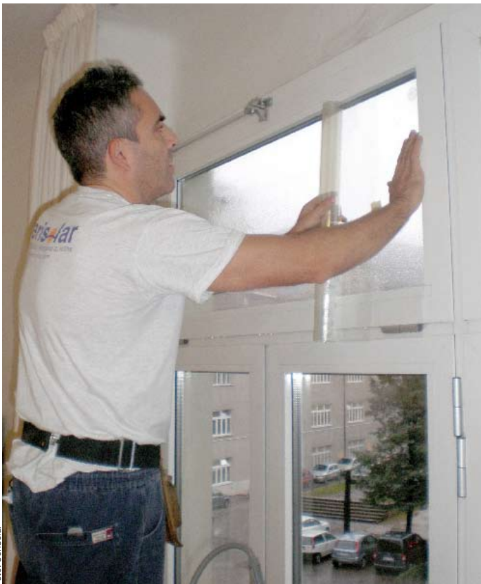
Die Experten von Serisolar überprüfen das Glas mit einem Laserinstrument und wandeln es durch das Anbringen einer Klebefolie in Sicherheitsglas um
