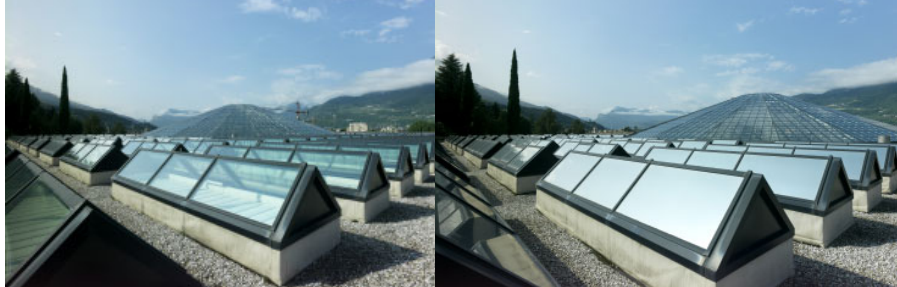
Mart Rovereto, prima (a sx) e dopo l'installazione Serisolar
