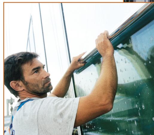
La schermatura delle vetrate della Fieramilano per il test termometrico comparativo
