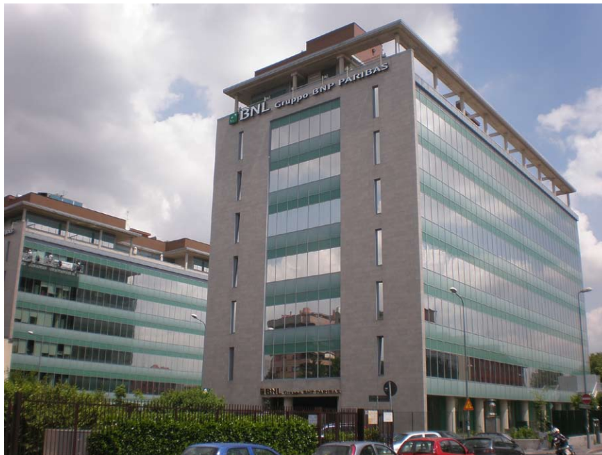
Foto des Bnl-Gebäudes vor Installation der Folien und nach Installation der Folien
